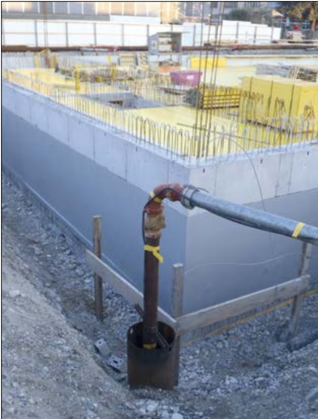
Flächenabdichtung im Unterterrainbereich
