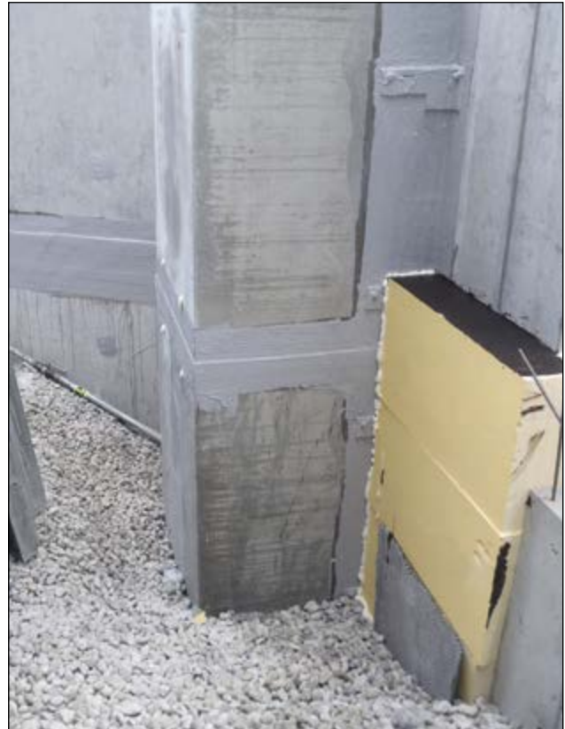
Abdichtung von Betonarbeitsfugen
