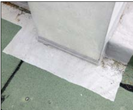
Alle Bilder dieser Seite: Abdichtungen von Schwellenschlüssen und Materialübergängen
