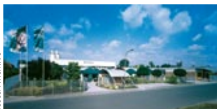
Silikal, Produktion und Verwaltung in Mainhausen / Silikal production and administration in Mainhausen, Germany.
